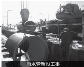
雨水管新設工事
